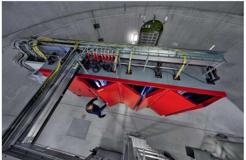
Ein ungewöhnlicher Serverraum: Diese Racks stehen in einem Windkraftwerk und werden direkt von den Windrädern mit Strom versorgt.
